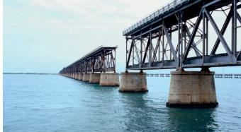
La **clasificación anticorrosiva C4** se caracteriza por una excelente protección anticorrsiva al nivel más alto. Para estas áreas de aplicación únicamente sistemas de pintura tricapa o bicapa de alto espesor son utilizados.
