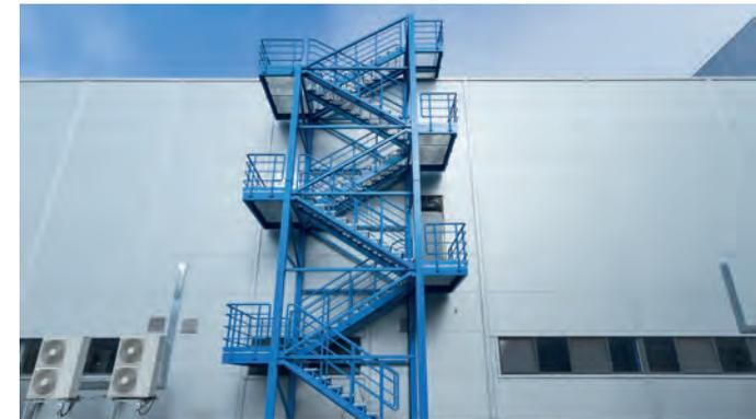
Die Korrosionsschutzkategorie **C5 (sehr starke Korrosivität)** steht für einen sehr anspruchsvollen Korrosionsschutz auf allerhöchsten Niveau. Zum Erzielen von hohen Schichtdicken werden fast ausschließlich zweikomponentige Lacksysteme eingesetzt.
