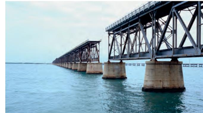
Die Korrosionsschutzkategorie **C4 (starke Korrosivität)** stellt einen hohen Anspruch an die verwendeten Lackkomponenten. Für diese Bereiche werden überwiegend nur 3-schichtige Aufbauten eingesetzt. Bei zweischicht Systemen kommen nur Dickschichtaufbauten zum Einsatz.
